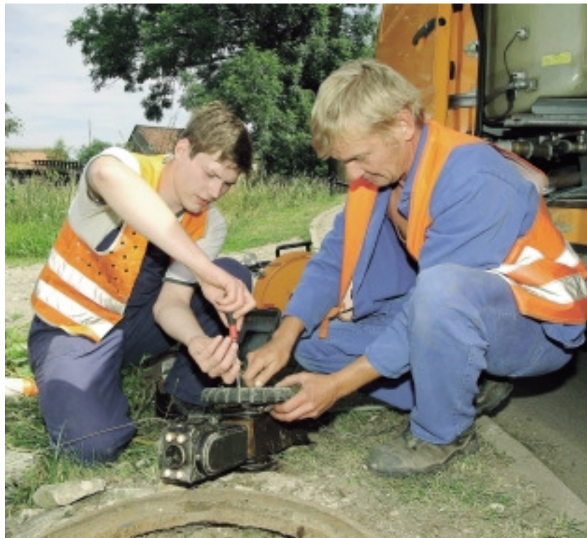
Arbeitseinsatz in Neundorf bei Weida: OTWA-Mitarbeiter Dieter Dinger und der Auszubildende Jan Säckel bereiten die Kamera für die Befahrung des Abwasserkanals vor.
